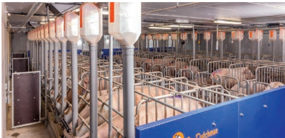
Применение объемных дозаторов для индивидуального кормления свиноматок при содержании в индивидуальных станках
