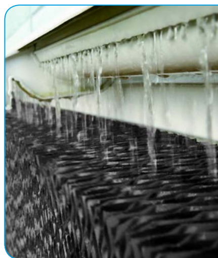
Распределение воды в охладителе с рамой ПВХ
