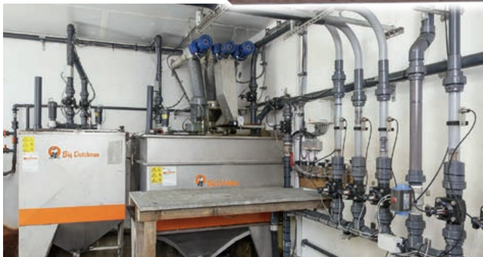
Система с 1 баком, БТВ и 4 тупиковыми линиями JET
